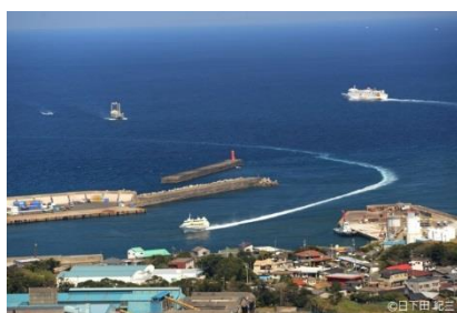
3-2 宮之浦港のフェリーと高速船の出入り
