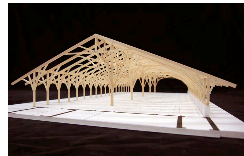
町民窓口棟架構
