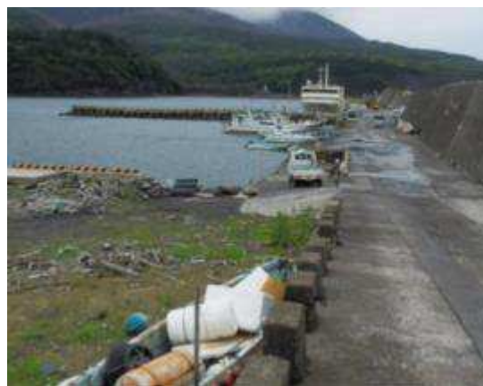
① 離・接岸の岸壁
