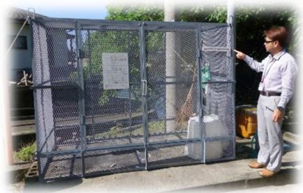
ゴミステーションの更新（栗生区）
