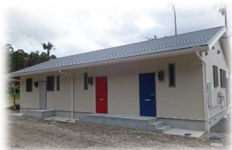
定住促進住宅（外観）
