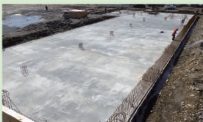
窓口棟耐圧コンクリート打設
