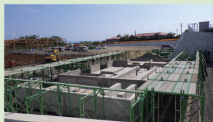
機械室基礎完了
