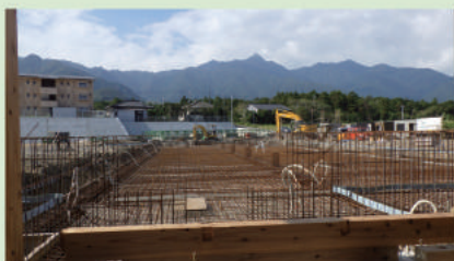
窓口棟鉄筋工事
