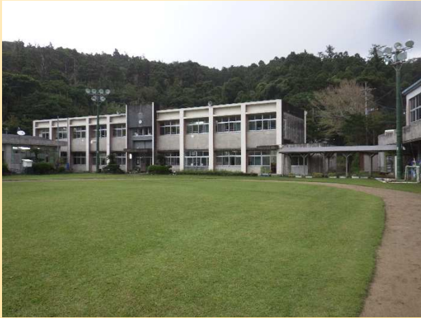
解体前の金岳小学校校舎全景
