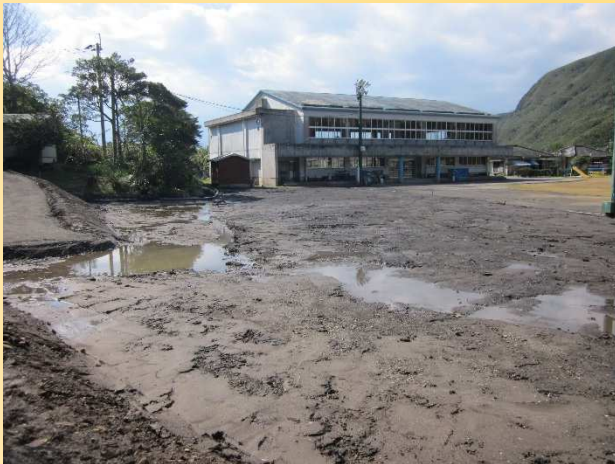
解体後の様子（校舎裏から）
