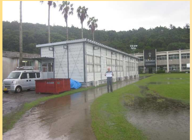
仮設校舎の設置状況
