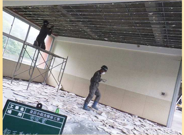
校舎解体中の様子（内部解体）
