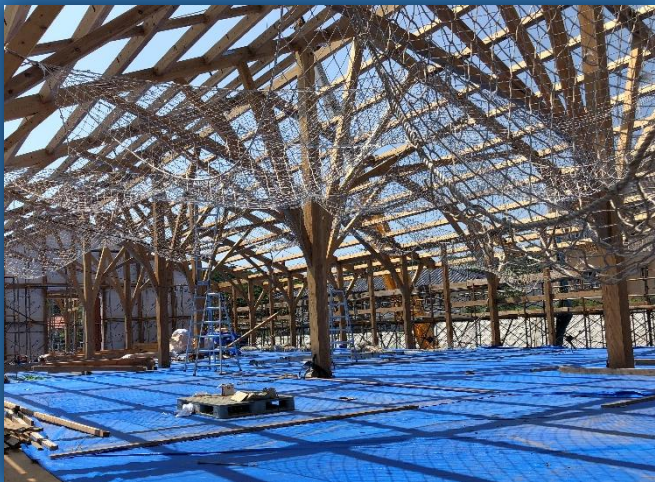
2階樹状トラス
