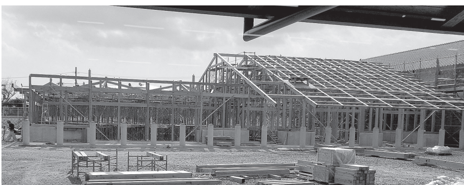
建設中の新庁舎議会棟
