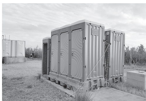
番屋ヶ峰避難所の屋外仮設トイレ
