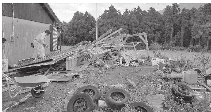
台風被害で倒壊した倉庫の解体
