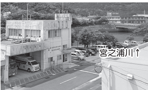
海抜2層に建つ消防署北分遣所
