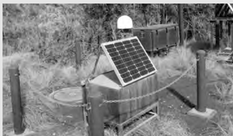
口永良部島に設置してあるGNSS観測点
