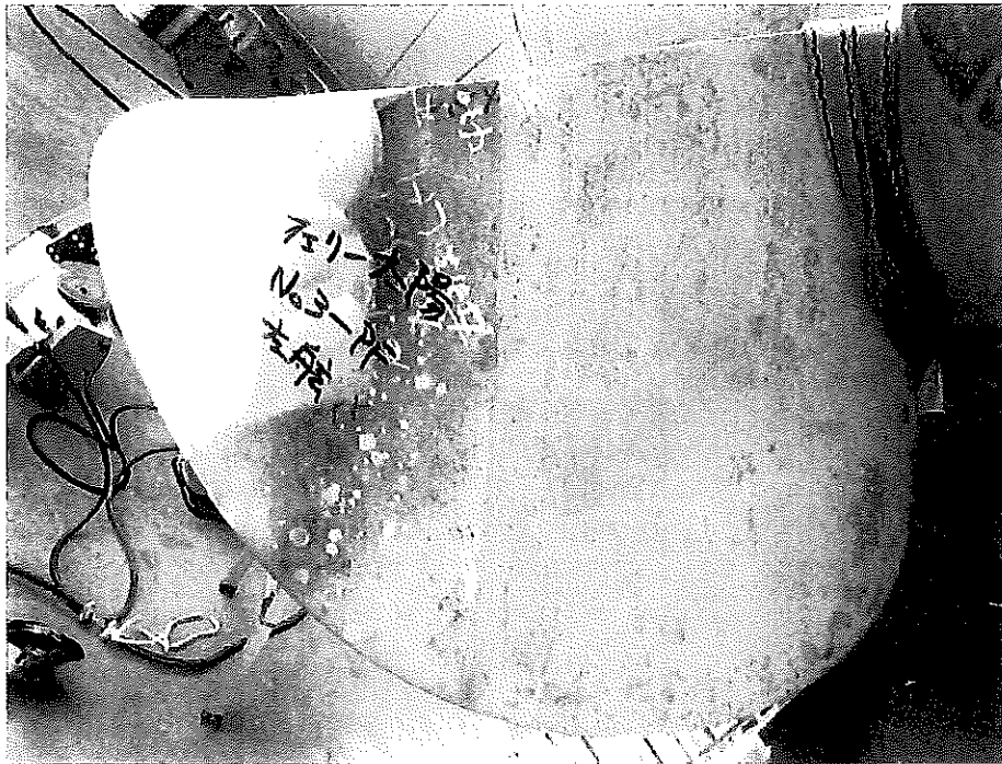
左回転 No.3翼 圧力面側
