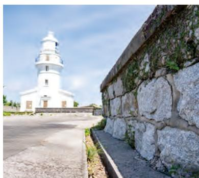
石塀は、屋久島灯台とともに建設され、屋久島の花崗岩製で高さは約1.4m。下部の石積み部と、上部のレンガ積み部をモルタルで覆い整形する二段構造により築かれています。
