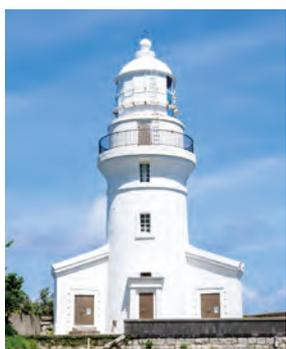
灯台は、3階建て総高約19・6mの凸状円筒形灯台で、レンガ積みを基本としていますが一部は石材が使用されており、床や螺旋階段は、溶結凝灰岩で造られています。
