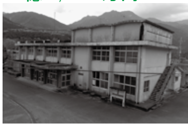
R 3 年度に解体工事を行っている旧宮之浦支所
