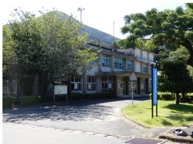
旧役場宮之浦支所
