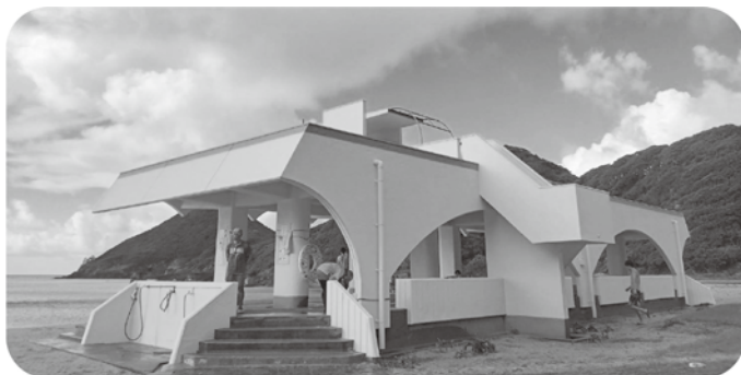
工事が完了した一湊海水浴場施設
