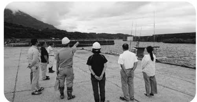
工事が完了した湯泊港の堤防
