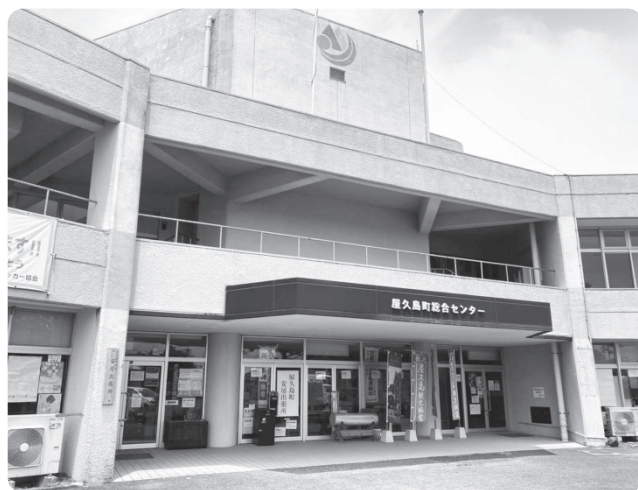
子育て支援センター開設に伴い内部の 変更があった総合センター
