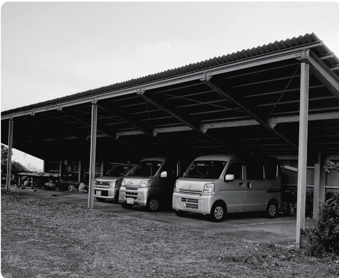
解体後移設予定の車庫
