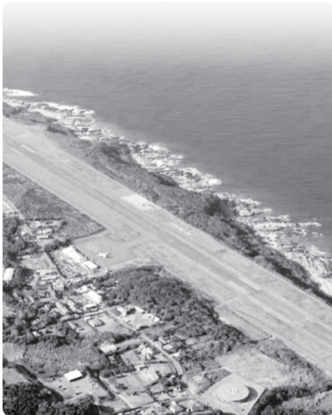
延伸事業手続きが進む屋久島空港滑走路
