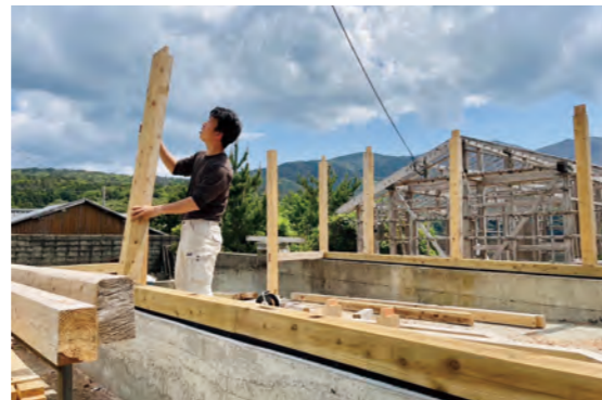
▲令和5年4月10日、前年度作った基礎の上に、土台を組んで棟上げを行いました
