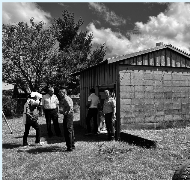
台風で破損した永田小学校の倉庫
