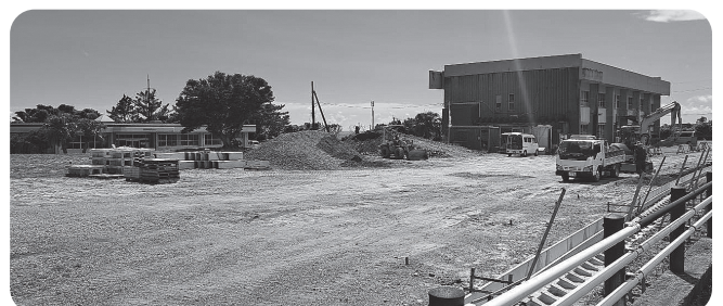
現尾之間支所庁舎跡地 奥は尾之間公民館
