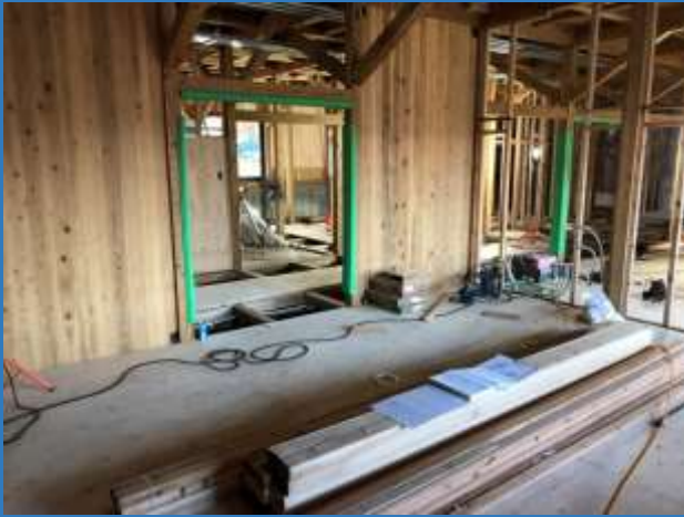
1階の CLT を使った耐力壁
