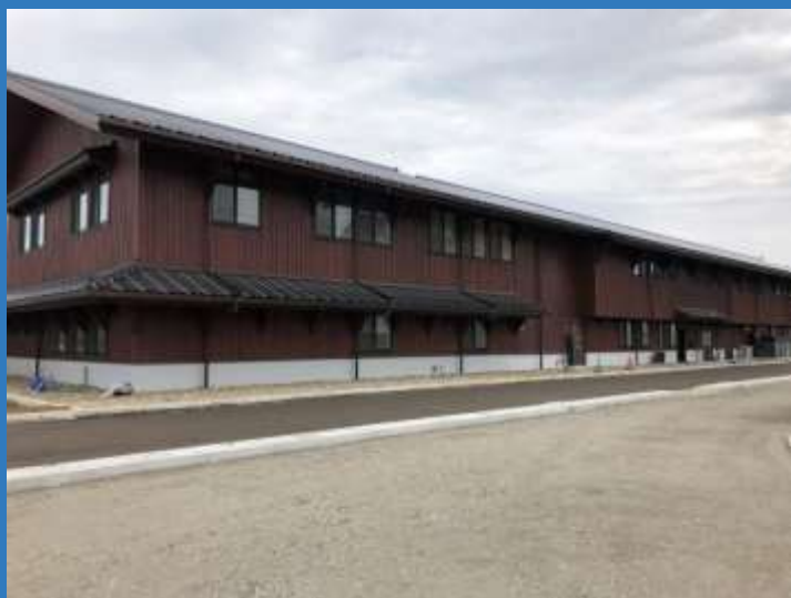
事務棟裏手側
